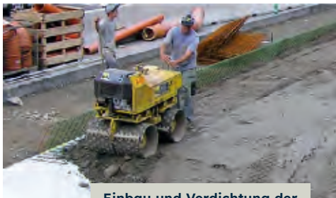
Einbau und Verdichtung der ersten Füllschicht
