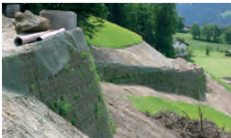
Einbau und Verdichtung der ersten Füllschicht
