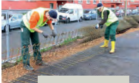
Setzen der Schalungselemente
