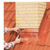
Die Wakaleiste ist durch die leicht zu entfernenden Stanzungen einfach mit Schlagdübel zu montieren und dank der beidseitigen Farbbeschichtung wahlweise in rot oder braun zu verwenden.
