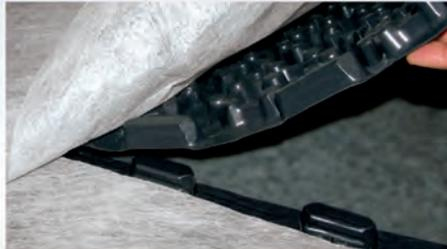
Die Elemente werden mittels einrastender Noppen an den Längsseiten untereinander fixiert. Dadurch ergibt sich eine durchgängige Schutzschicht für die Dachabdichtung.
