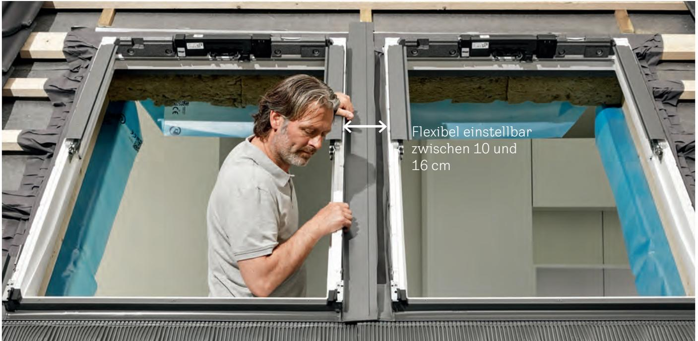
Die flexible Rinne ist unsere innovative und patentierte Lösung, um den Einbau von Fensterkombinationen noch einfacher zu machen. Sie kann einfach auf jede Breite zwischen 10 und 16 cm angepasst werden.
