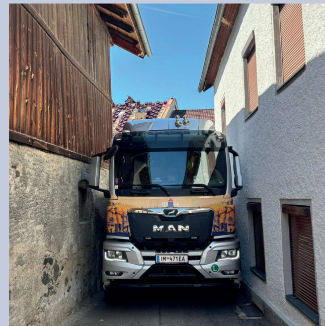
Besonders enge Anfahrt zur Baustelle in Silz
