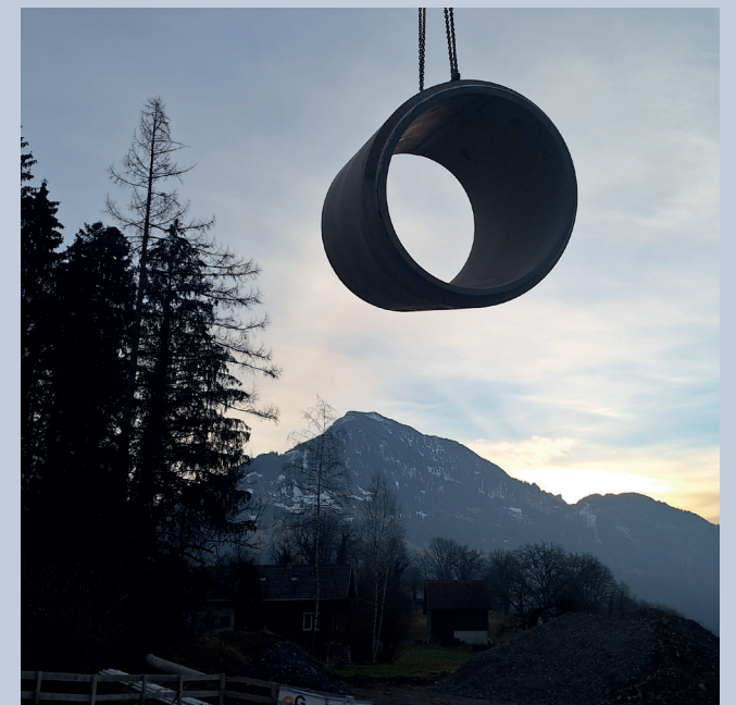
Stahlbetonrohr für Thüringen-Montjola in unwegsamem Gelände
